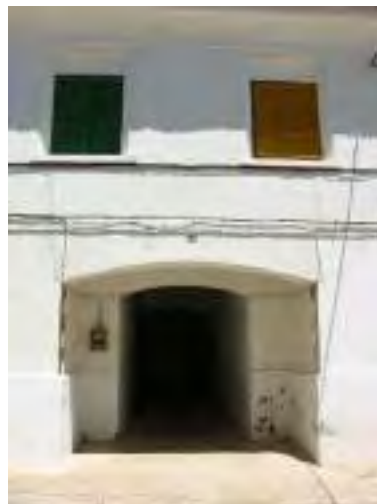
M4 / Fachada S / puerta común 2 viviendas a patio
