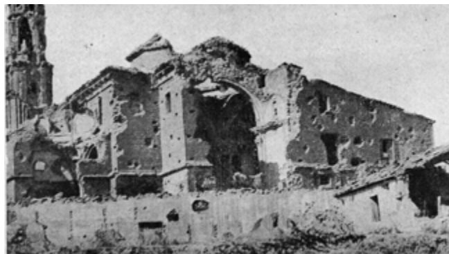
“Iglesia y Convento de San Agustín. El ábside y la cúpula totalmente abatidos por la artillería”. Foto del Archivo Municipal.
