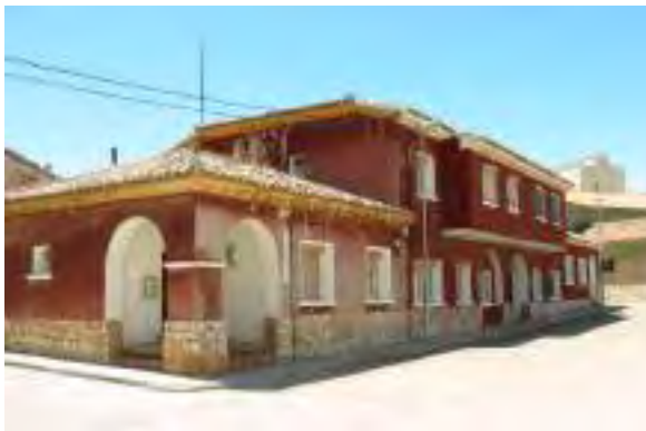
Manzana 6.2 / Fachada N
