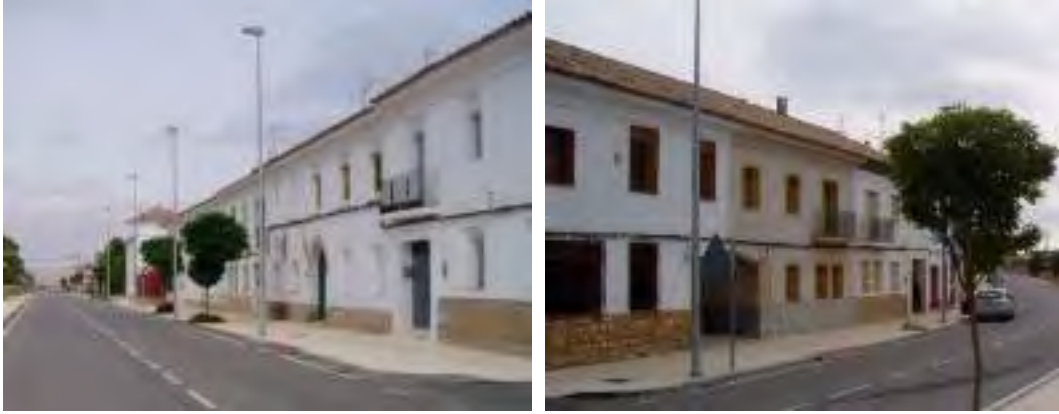
Carretera de Cariñena, cruce Calle de N o .S a . del Rosario / Manzana 2 fachada S
