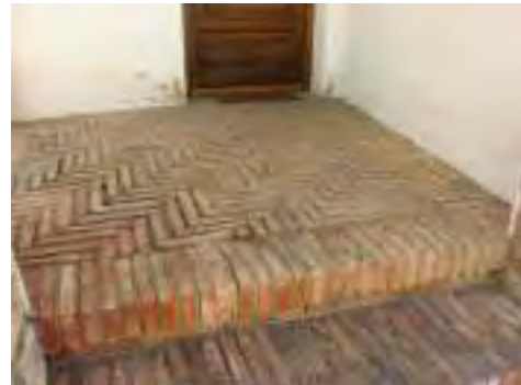
Pavimento del porche de acceso a una vivienda
