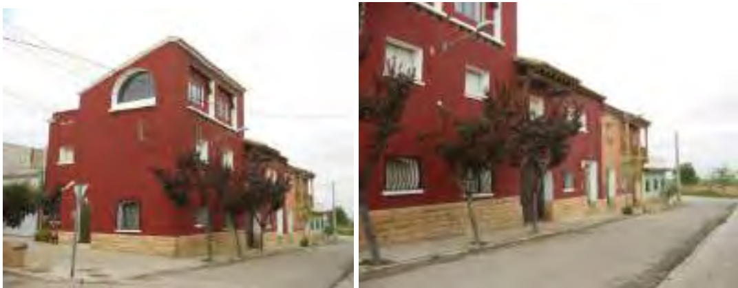
Esquina SE y fachada E
