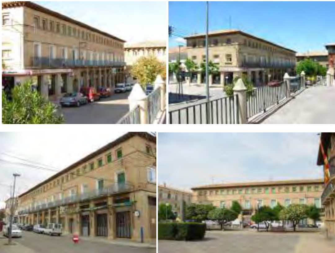
Bloque en fachada E hacia la Plaza del Ayuntamiento
