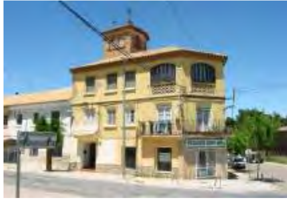
M3 / Esquina SE
