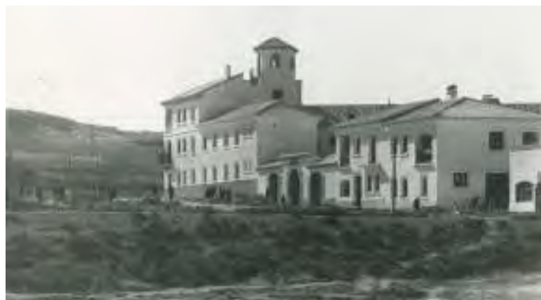
Fotos de la construcción (manzanas 3 y 5)
