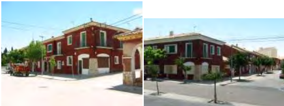
M7 / fachada N
