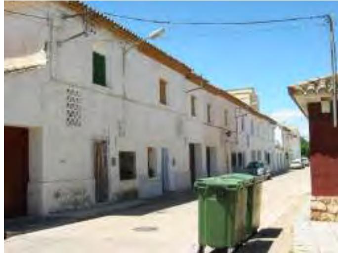
M4 / Fachada N
