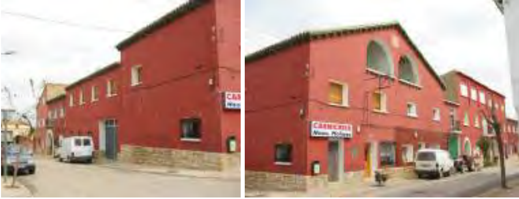
Fachada O y esquina SO
