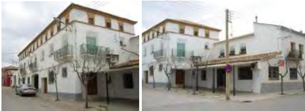
Fachada E y esquina E-N
