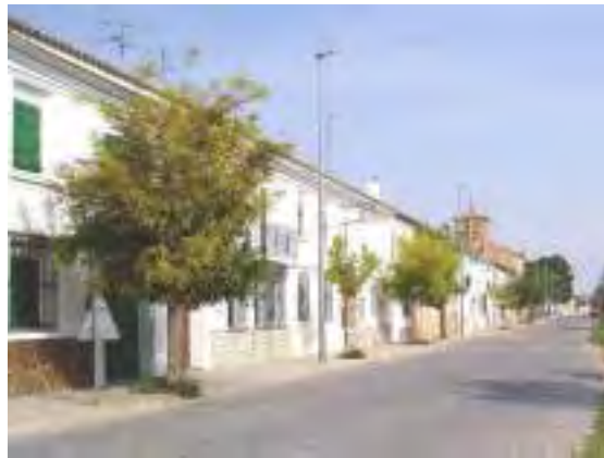
Carretera de Cariñena / Manzanas 2-3
