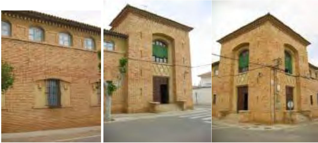
Detalle fachada S y torreón esquina SE
