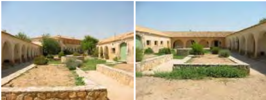
Fachada posterior y patio en la actualidad.
