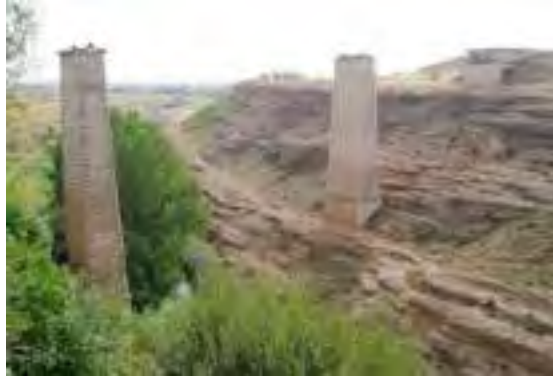
Pilastras de puente del antiguo ferrocarril sobre el río Aguasvivas
