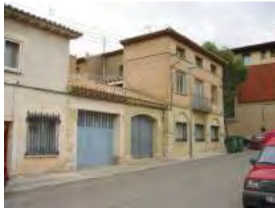
Fachada O (M-23)
