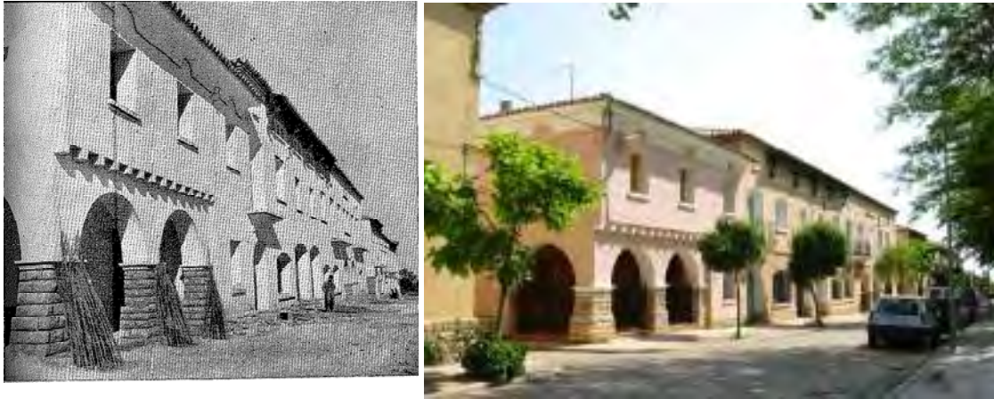
Fachada S (esquina SO)
