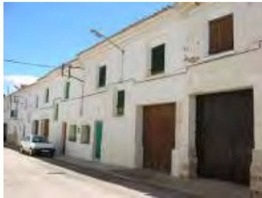
M1 / fachada N
