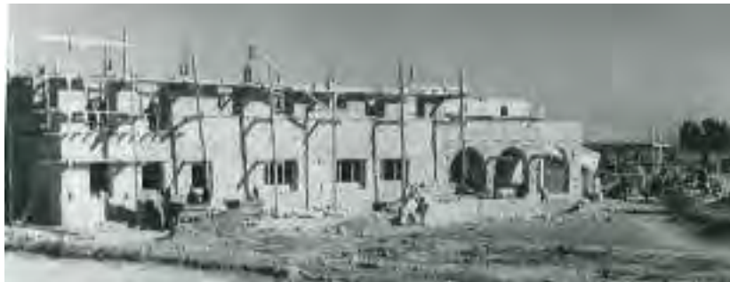
El edificio en construcción
