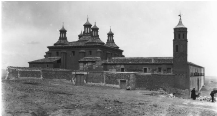
Vista de conjunto (Foto: J. Mora Insa / AHP Zaragoza)
