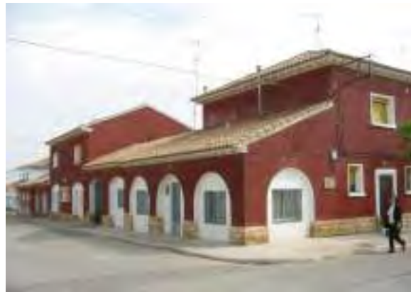
Fachada O (esquina SO)
