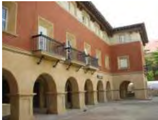
Fachada del Teatro a la Plaza
